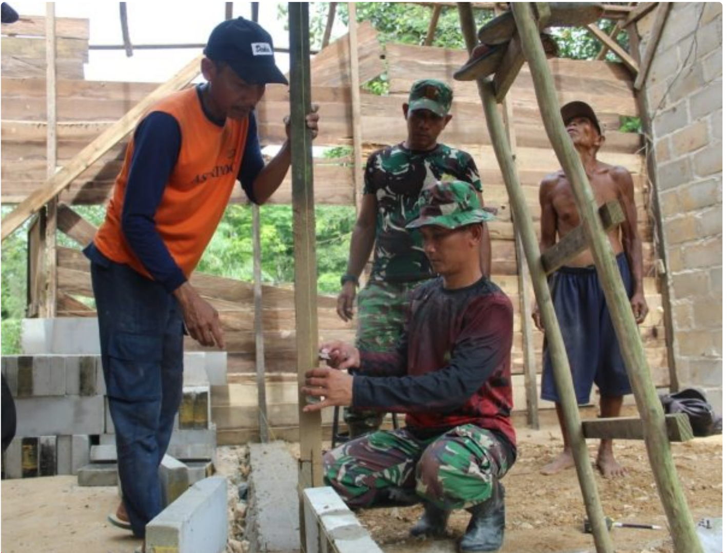
Sasaran Bedah Rumah, Sudah Tahap Pemasangan Dinding
