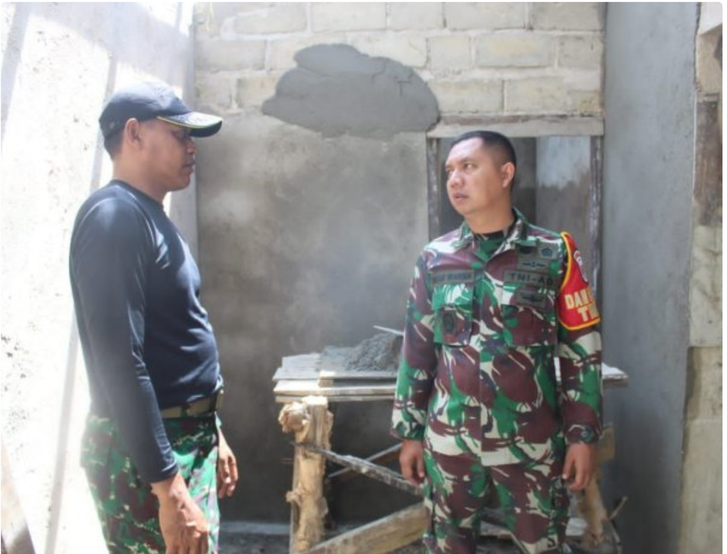
Dinding Rumah Mbah Yadi Mulai Di Plester Satgas TMMD
